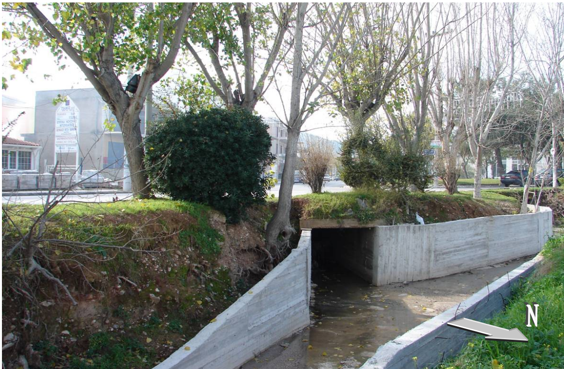
Εικόνα 2-19: Ο χείμαρρος της Αγίας Αικατερίνης νοτιοανατολικά της πόλης της Μάνδρας στην τομή του με τον Σούρες. Η αλλοίωση των γεωμετρικών χαρακτηριστικών της κοίτης ξεκίνησε στα τέλη της δεκαετίας του 1970, κατά την κατασκευή του οδικού δικτύου και συνεχίζεται μέχρι σήμερα. Οι διαστάσεις αντί να αυξηθούν προκειμένου να ανακουφίσουν τις επιπρόσθετες υδάτινες μάζες λόγω τσιμεντοποίησης της επιφάνειας κατάκλυσης, έχουν υποπολλαπλασιαστεί. Σήμερα είναι 1,5x1,5 m, ενώ το πλάτος θα έπρεπε να ήταν τουλάχιστον όσο το πλάτος του οδοστρώματος, το οποίο άλλωστε έχει αντικαταστήσει την κοίτη (περίπου 6 m).
