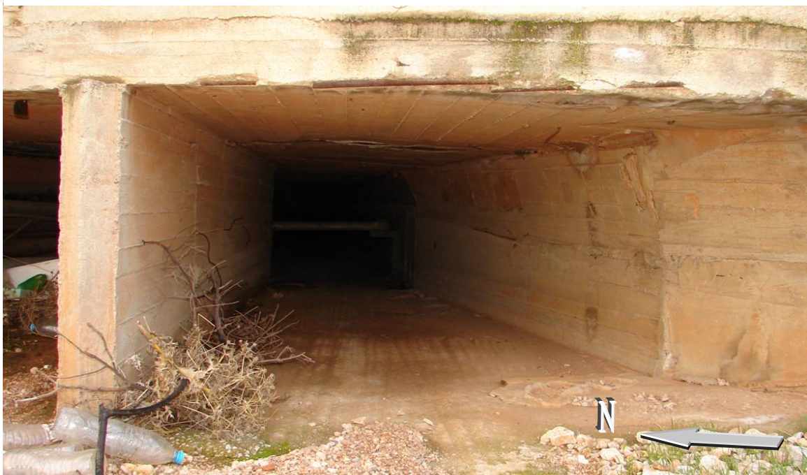
Εικόνα 2-13: Η κοίτη του χ. Σούρες κάτω από τη ΒΑΚΟΝΤΙΟΣ ΑΕΒΕ – Δεξί τμήμα της διατομής διαστάσεων 2,20 m πλάτος x 1,20m ύψος, σχήματος ορθογώνιο παραλληλογράμμου. Στο βάθος η διατομή αλλάζει σε σχήμα τετραγώνου μικρότερων διαστάσεων (περίπου 1,2 m x 1,2). Η αλλαγή σε στενότερη διατομή δημιουργεί το φαινόμενο του σίφωνα (στομίου μπουκαλιού), με αύξηση της ταχύτητας ροής στην έξοδο αλλά συσσώρευση στην είσοδο. Το φαινόμενο αυτό είναι επιθυμητό και σχεδιάζεται μόνο στη περίπτωση των υδροηλεκτρικών φραγμάτων, για την μέγιστη εκμετάλλευση της ενέργειας ταχύτητας νερού. Υδραυλικός σωλήνας στο διάμεσο της διατομής, έτοιμος να λειτουργήσει σαν ανασχετικό στοιχείο φερτών υλικών στοιχείων με αποτέλεσμα την απόφραξη. Στο βάθος αλλαγή σχεδόν 90° προς βορά της εν λόγω κατασκευής, υποχρεώνει τα νερά σε επιβράδυνση δηλ σε έναν ακόμα παράγοντα κατάκλισης της ανάντη περιοχής.
