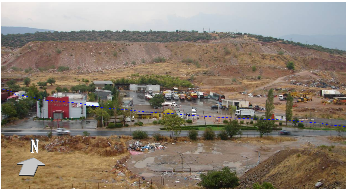
Εικόνα 2-15: Η κοίτη του χ. Σούρες δεν είναι δυνατόν να διακριθεί αφού έχει κατά σειρά καταπατηθεί από τα δυτικά προς τα ανατολικά, από την Βακόντιος ΑΕΒΕ, από ιδιωτικό κέντρο διασκέδασης και το εργοτάξιο του δήμου Μάνδρας. Ο άξονας του χειμάρρου απεικονίζεται με διακεκομμένη μπλε γραμμή και είναι σχεδόν παράλληλος προς τον άξονα της Παλαιάς Εθνικής Οδού Αθηνών – Θηβών που διακρίνεται στο κέντρο της εικόνας. Το καλοκαίρι του 2008 στο εργοτάξιο του Δήμου Μάνδρας έγινε διευθέτηση της κοίτης, με την τοποθέτηση αγωγού κυκλικής διατομής φ200, ενώ έχει πλήρως ασφαλτοποιηθεί η εκατέρωθεν αναβαθμίδα κατάκλισης. Η εν λόγω εικόνα λήφθηκε μετά από καλοκαιρινή νεροποντή της 10 ης ΑΥΓ 2008 κατά την οποία παρατηρείται κατάκλιση του εργοταξίου από νερά, τα οποία εκτός από την επέμβαση της Βακόντιος, πιθανόν να οφείλεται και την πρόσφατη αυτή του εργοταξίου. Το πάθημα του 1996 όπως φαίνεται δεν έγινε μάθημα.
