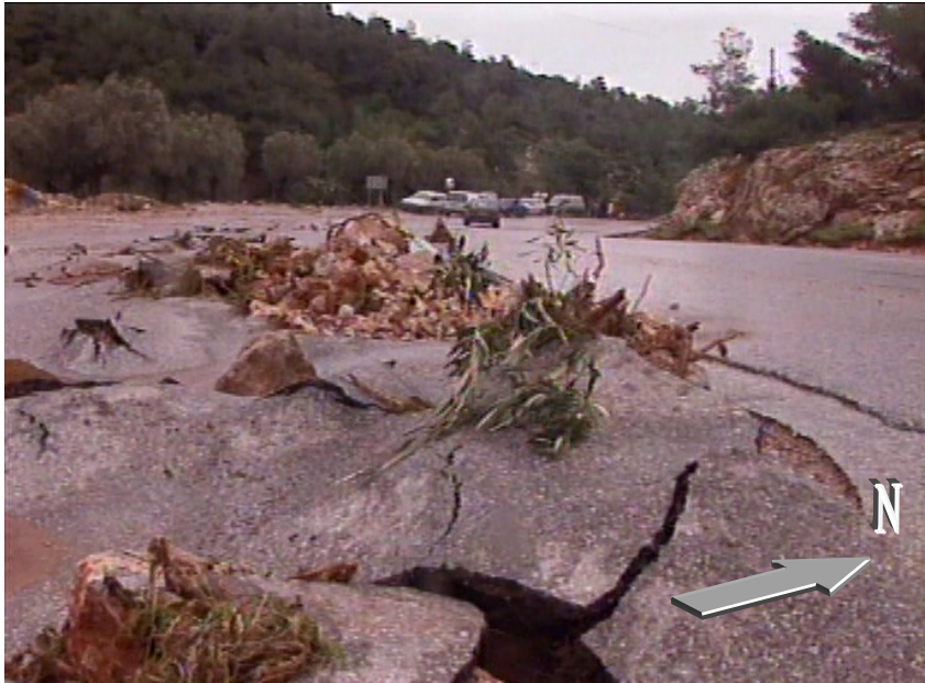
Εικόνα 6-1: 8 ο Χιλιόμετρο Π.Ε.Ο Ελευσίνας – Θηβών, 300 μέτρα κατάντη του σημείου που απεικονίζεται στην εικόνα 6-1. Διακρίνεται η στερεοπαροχή αλλά και η διαβρωτική Ενέργεια του Χειμάρρου. Στο βάθος η στερεοπαροχή του Σούρες, έχει εξισώσει το υψόμετρο του οδοστρώματος και το έχει κατακλύσει με φερτές ύλες.
