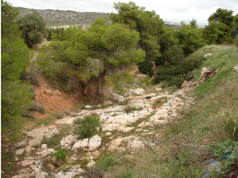
Εικόνα 8-4: Ρέμα Αγ. Αικατερίνης 100 μέτρα ανατολικά του σημείου AGK4. Η θέση όπου προτείνεται να κατασκευαστούν τα ανασχετικά φράγματα και η γεωτρηση εμπλουτισμού. Μεταξύ άλλων είναι εμφανείς α) η πρακτικότητα που προσφέρει η μορφολογία κοίτης και πρηνών αναβαθμίδων, που αποτρέπει την εκτενή παρέμβαση μηχανικών μέσων για την κατασκευή, β) το καρστικοποιημένο δάπεδο της κοίτης το οποίο θα λειτουργήσει ευεργετικά για τον εμπλουτισμό.
