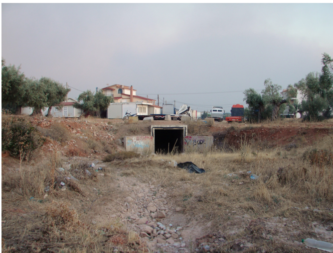
Εικόνα 8-2: διευθέτηση του χειμάρρου Μικρού Κατερινιού στο σημείο που υποδεικνύεται από το χάρτη 7-6 σαν υψηλής επικινδυνότητας και τρωτότητας περιοχή
