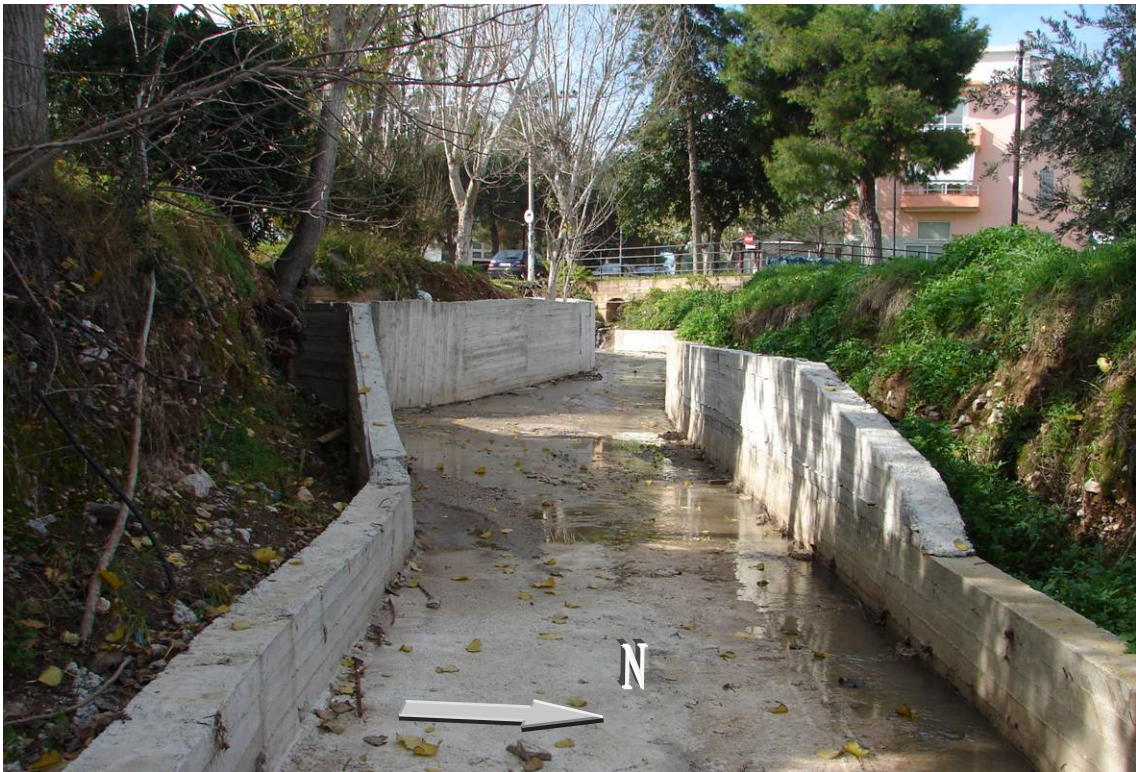
Εικόνα 2-20 & 2-21: Στην πάνω εικόνα ο χείμαρρος Σούρες μετά την τομή του με τον κλάδο της Αγίας Αικατερίνης τον Νοέμβριο του 2007. Στην κάτω εικόνα το ίδιο ρέμα σήμερα. Η τιμεντοποίηση του δαπέδου και τμήματος των πρανών, θα προκαλέσουν διαφορετική διάβρωση και υποσκαφή του τεχνικού έργου, αλλά και επιπρόσθετη διάβρωση των αναβαθμίδων εκατέρωθεν.
