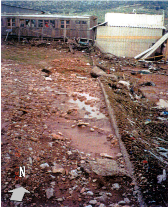
Εικόνα 2-14: Το εργοτάξιο του δήμου Μάνδρας (κατασκευασμένο εγκάρσια στην κοίτη του χ. Σούρες) την επομένη του πλημμυρικού επεισοδίου της 27 ης ΙΑΝ 1996. Είναι τοποθετημένο ανατολικά της Βακόντιος ΑΕΒΕ. Οι καταστροφές που απεικονίζονται δεν οφείλονται μόνο στο ακραίο πλημμυρικό επεισόδιο, αλλά και στην επέμβαση της κοίτης λόγω κατασκευής της βιομηχανίας, που είχε σαν αποτέλεσμα την αύξηση της ταχύτητας ροής των υδάτων (βλ εικ 1-10 & 1-11) . Εργοταξιακά αυτοκίνητα, περνοφόρα οχήματα, φορτηγά και άλλα χρήσιμα υλικά που θα ήταν απαραίτητα για την αντιμετώπιση της κατάστασης στις πρώτες ώρες της κρίσης, έχουν παρασυρθεί και έχουν τεθεί εκτός λειτουργίας. Ο πληθυσμός μέσα στην πόλη αναγκάστηκε να αντιμετωπίσει μόνος τα νερά και τις φερτές ύλες, ώσπου να έρθει βοήθεια από τους όμορους δήμους που επλήγησαν και αυτοί από τη ίδια θεομηνία.
