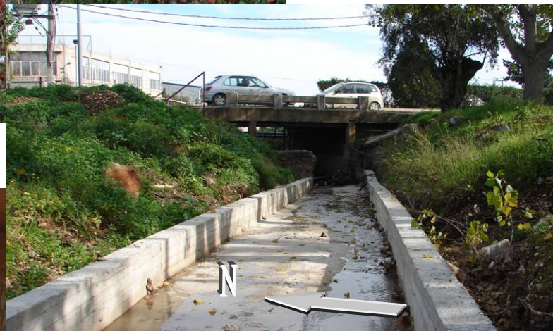
Εικόνα 2-22, 2-23 & 2-24: Χείμαρρος Σούρες και Παλαιά Εθνική Οδός Αθηνών – Θηβών. Στην αριστερή εικόνα είναι εμφανές το σημείο, όπου έχει αποτυπωθεί η υδάτινη μάζα της βροχόπτωσης της 17 Νοεμβρίου 2007 κατά την απορροή αιχμής. Σήμερα αυτό το σημείο έχει τιμεντοποιηθεί (κεντρική εικόνα). Αποτέλεσμα αυτού είναι η αλλαγή της ταχύτητας των νερών και η διαφορεική διάβρωση, η οποία είναι εμφανής κάτω από τα θεμέλια της γέφυρας. Δεν έχουμε παρά να περιμένουμε το πέρας του χρόνου για τις επιπτώσεις στα θεμέλια της γέφυρας, τα αίτια των οποίων θα αποδοθούν φυσικά στα «ακραία καιρικά φαινόμενα».
