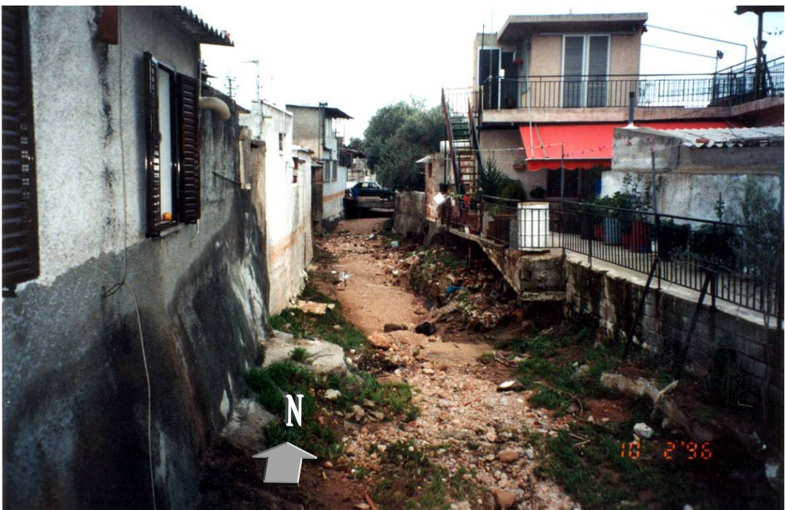
Εικόνα 2-7: Η κοίτη του χ. Σούρες στη συνοικία Πατράκωστα μερικές μέρες μετά το πλημμυρικό επεισόδιο της 27 ης Ιαν 1996. Διακρίνονται α) η ενέργεια του χειμάρρου που έχει αποτυπωθεί στην τοιχοποιία, σε ύψος μεγαλύτερο από εκείνο του γεφυριού στο βάθος, β) ο εγκιβωτισμός της κοίτης από παράνομες κατασκευές επί της κοίτης και η εξαφάνιση του φυσικού πεδίου κατάκλισης γ) η γέφυρα στο βάθος με ανεπαρκή διαστασιολόγηση, όπως αποδεικνύεται από τα νεονότα.
