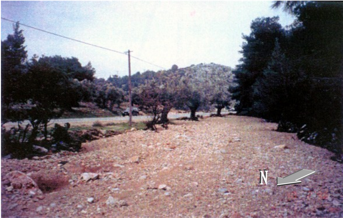
Εικόνα 2-8: Π.Ε.Ο. Αθηνών – Θηβών δύο ημέρες μετά την καταστροφή της 27 ης /1/1996. Η εικονιζόμενη περιοχή βρίσκεται 1Km κατάντη του σημείου της Εικ. 2-1. Είναι διακριτή η στερεοπαροχή του Σούρες που έχει εξισώσει το υψόμετρο του οδοστρώματος.
