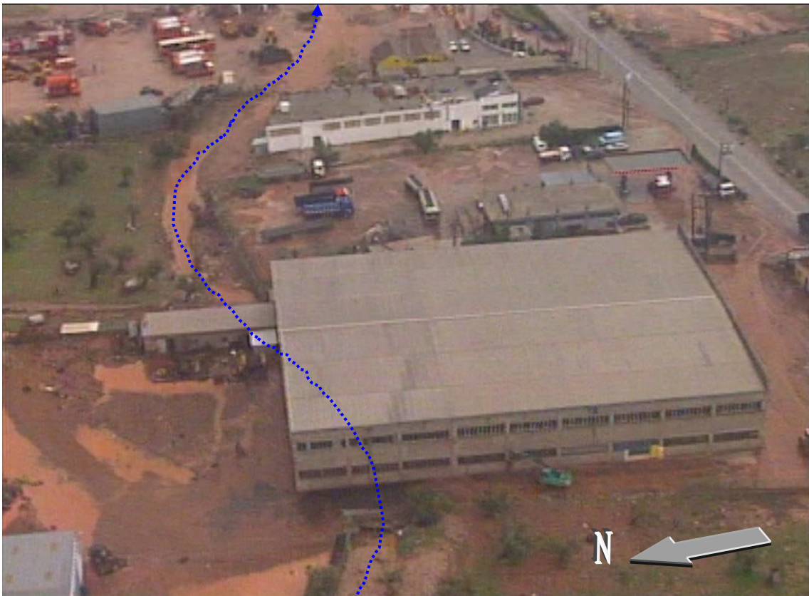
Εικόνα 2-9: 27/1/1996 Απεικονίζονται οι καταστροφές των πλημμυρικών απορροών του χειμάρρου Σούρες σε κατασκευές δομημένες πάνω στην κοίτη του. Διακρίνονται σε πρώτο πλάνο η βιομηχανία ΒΑΚΟΝΤΙΟΣ ΑΕΒΕ και στο βάθος το εργοτάξιο του Δήμου Μάνδρας. Ενδιάμεσα άλλες επιχειρήσεις που επλήγησαν, κατασκευασμένες στη ζώνη κατάκλυσης. Στο κάτω αριστερό και δεξιό τμήμα της φωτογραφίας διακρίνεται η στερεοπαροχή του χειμάρρου λόγω του φραγμού που έχει προκαλέσει η ΒΑΚΟΝΤΙΟΣ ΑΕΒΕ
